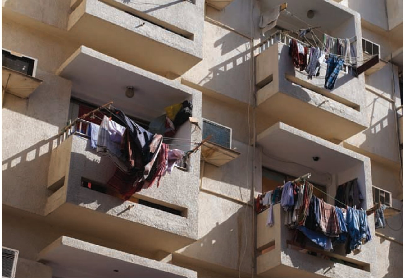
مساجن منخفضة التكاليف في منطقة ديرة في دبي، الإمارات العربية المتحدة. © تانوكي فوتوغرافي / أي ستوك فوتو
