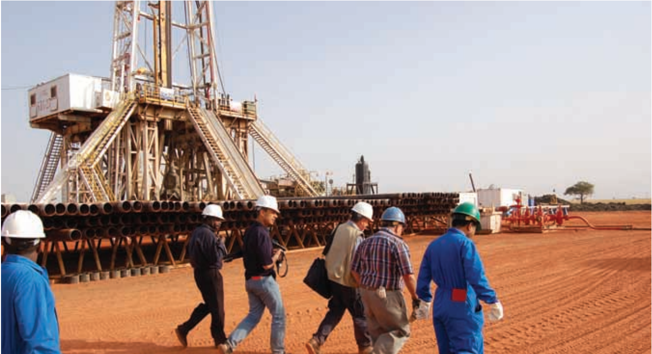
أغطية بئر مرتبة تحت جهاز حفر من نوع هجليج في ولاية جنوب كردخان. © برنامج الأمم المتحدة للبيئة
